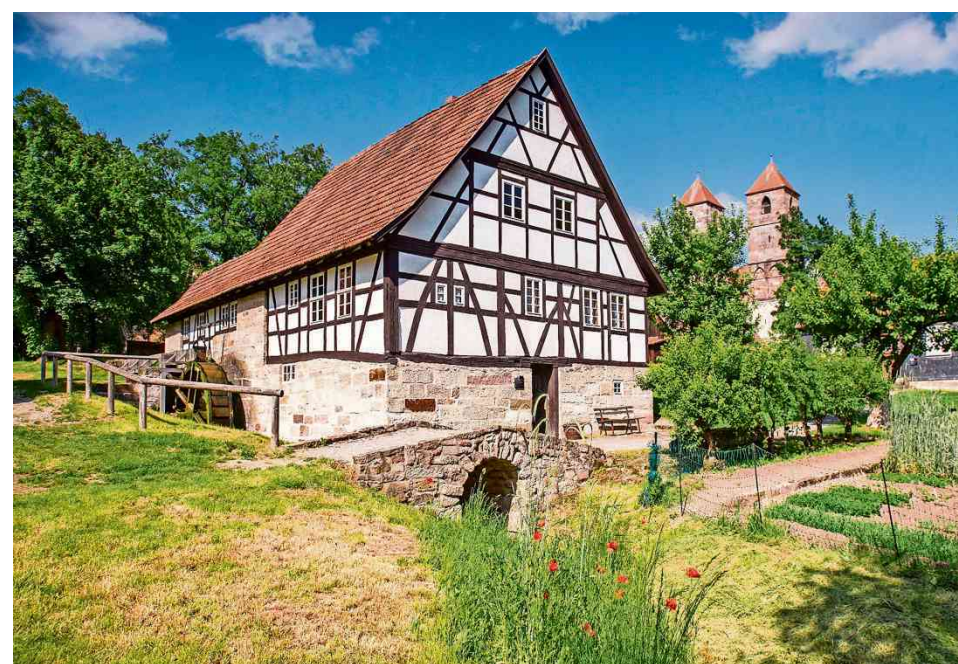
Im Kloster Veßra wird erklärt, was Nachhaltigkeit mit historischen Fachwerkhäusern zu tun hat, die schon Jahrhunderte stehen.
